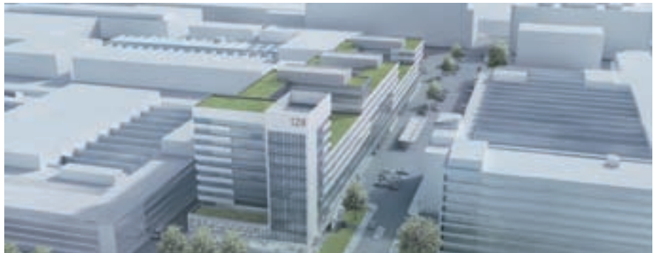
Der Neubau des Gebäudes 128 für die RD-Beschäftigten verzögert sich aufgrund der schwierigen Baubedingungen
